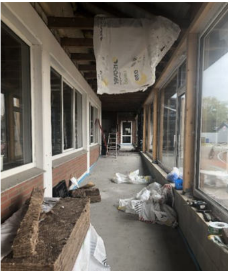
Innenausbau mit Deckendämmung und -sanierung
