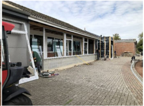
Montage von Fensterrahmen
