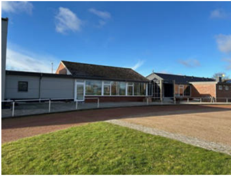
Fast fertige Fassade
