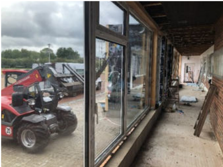
Einsetzen der schweren 3-fach Verglasung
