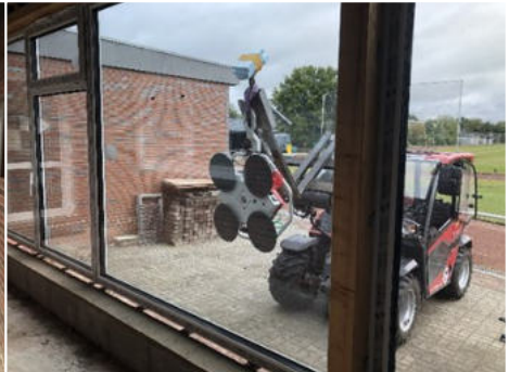
Einsetzen der schweren 3-fach Verglasung
