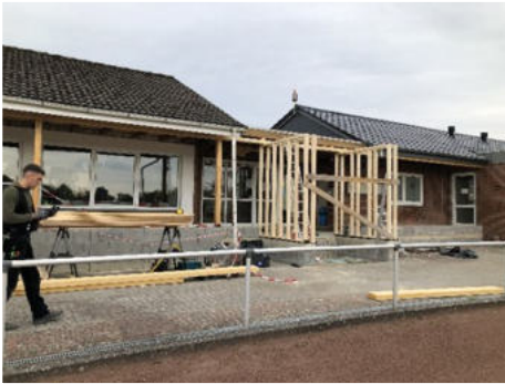
Montage von Holzständern für Fenster und Eingangsbehausung
