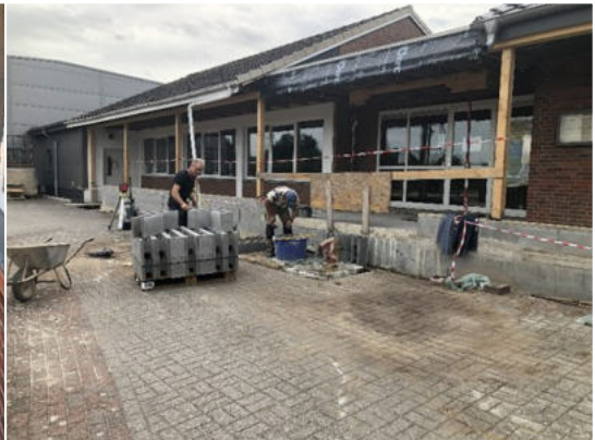
oben: Erstellung von Fundament und Sockel
