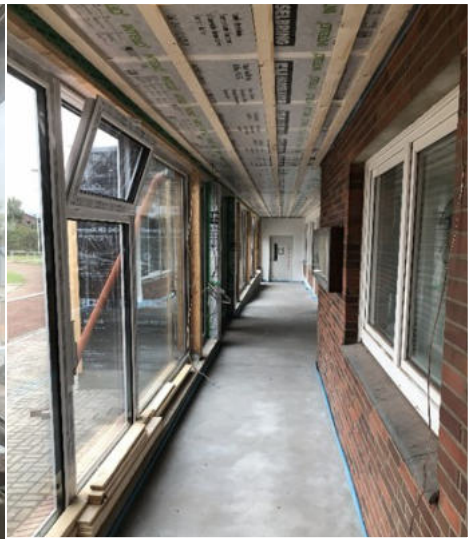
Innenausbau mit Deckendämmung und -sanierung
