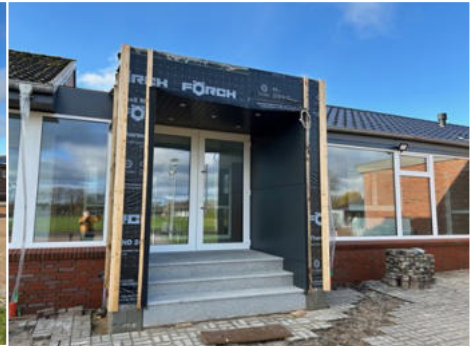
Fast fertige Einhausung für den Eingang
